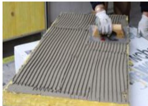
La colocación de los paneles aislantes debe realizarse en horizontal, de abajo hacia arriba, con las juntas no alineadas, partiendo desde el perfil de arranque. Las juntas de placa no deben quedar alineadas con las jambas o aristas de puertas, ventanas, etc. Por tanto, los paneles deben cortarse en "L" de modo que revistan todo el ángulo y ofrezcan resistencia a las tensiones ocasionadas por los movimientos de los distintos materiales.
